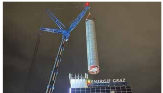
Einheben neuer Speichereinheiten beim Power Tower (Foto: Martin Matzi/ Energie Graz)
