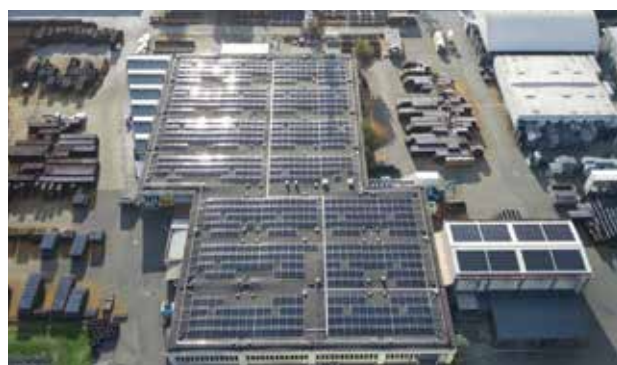
PV-Anlage (Foto: AVI GmbH)
