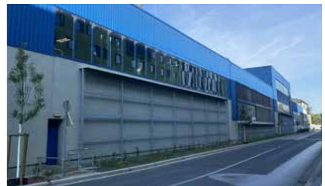
Begrünung Köfflachergasse (Foto: Siemens Mobility Austria GmbH)
