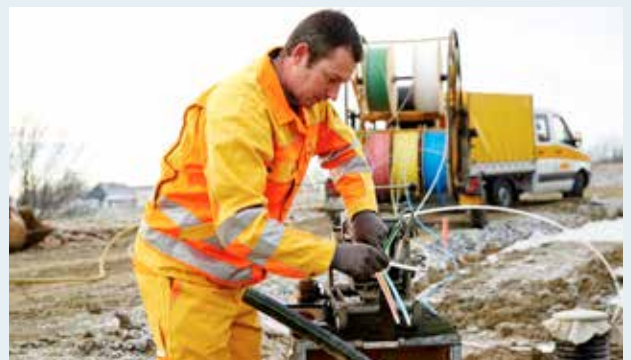
Foto: Konrad Beyer & Co. Spezialbau GmbH
