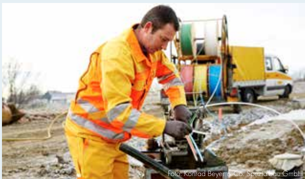
Foto: Konrad Beyer & Co. Spezialbau GmbH
