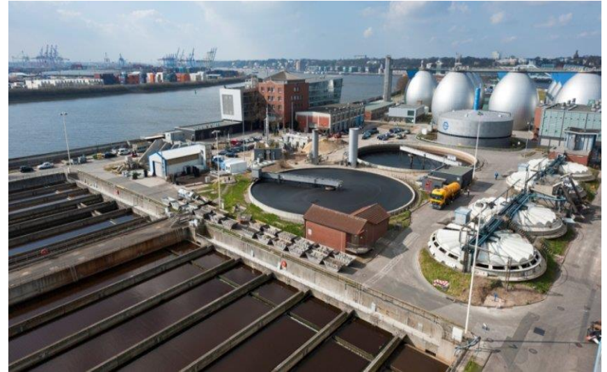
Kläranlage Köhlbrandhöft Foto: Hamburg Wasser
