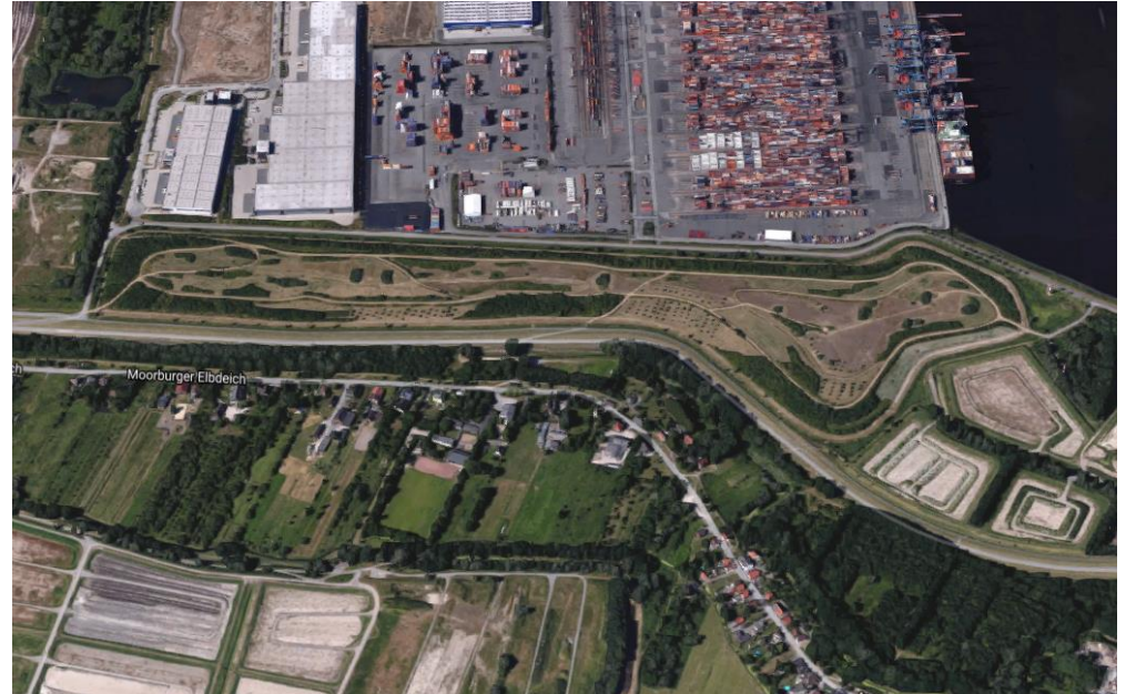
Altes Spülfeld südlich Containerfläche Altenwerder
